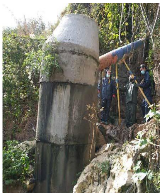
Imagen 1. Última avería del colector en la margen derecha (21-09-2020)
