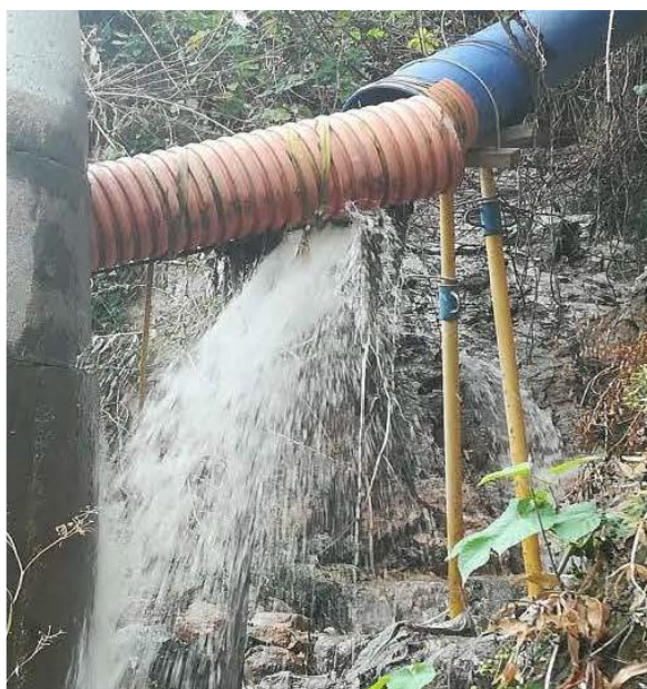
Imagen 1. Última avería del colector en la margen derecha (21-09-2020)
